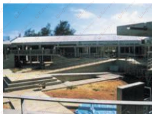
北大東島長期宿泊施設（屋根）
