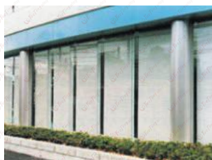
沖縄電力牧港本社ビル （柱カバー）
